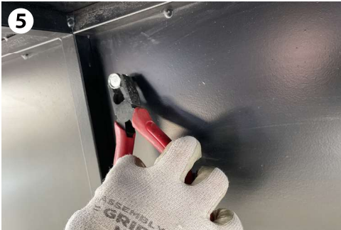
▲ それぞれ4点ぼボルトをしっかりと固定します。
